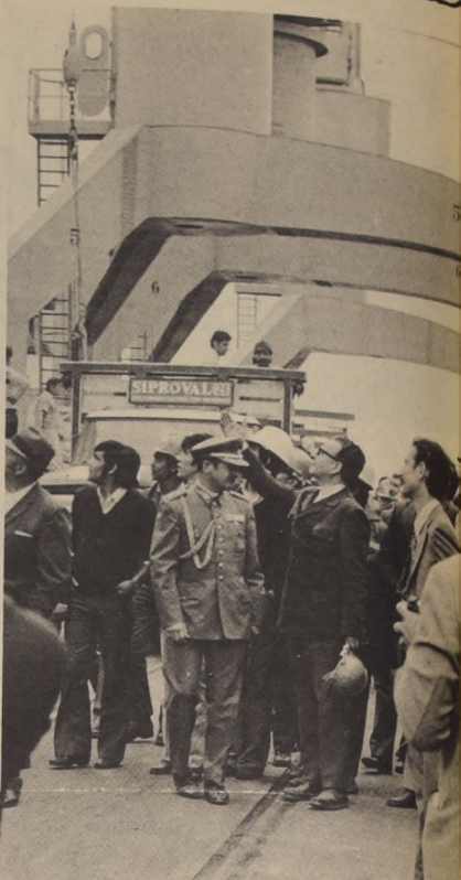
El Presidente Allende, durante su visita a la obra de Remodelación del Espigón de Valparaíso, la semana pasada, en los momentos que observa el montaje de la primera etapa, de las grúas Mann.
