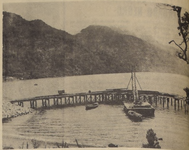
Muelle reconstruido en puerto de Chacabuco.
