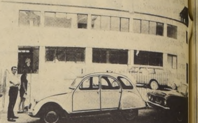
NUEVO EDIFICIO de la Dirección de Aguas, recientemente inaugurado. Permitirá concentrar las diversas secciones de esta repartición y de esta manera prestar un mejor servicio al público.
