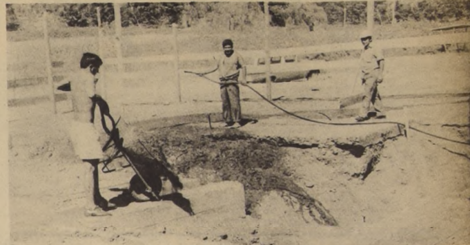
Un grupo de trabajadores da los toques finales a la construcción del porteo donde se inicia el proceso de distribución de agua potable a pobladas comunas del Gran Santiago.
