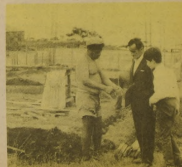
AQUI SE ESTA CONSTRUYENDO la fabrica de conservas INDAP, cuyas maquinarias se encuentran en la isla.
