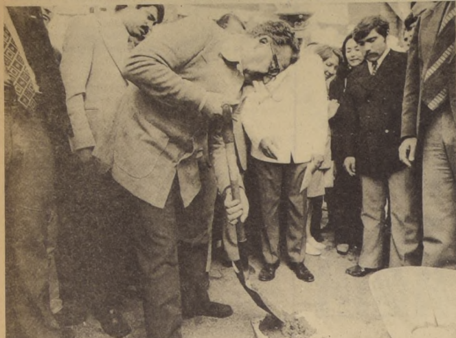
El Presidente Allende asistió a la colocación de la primera piedra del edificio de Los Trabajadores en Valparaíso, que beneficiará a cientos de hombres y mujeres de esta provincia. El Jefe del Estado en los instantes en que echa la primera palada de cemento.
