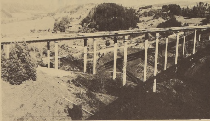
Abren tránsito de vehículos en el puente Malleco.
