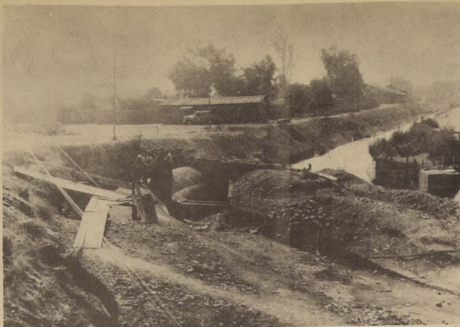
Abovedado "Colector H" del Zanjón de La Aguada
