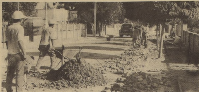
TRABAJOS QUE REALIZA la Corporación de Obras Urbanas en Villa Alemana, donde se pavimentarán 6.500 m 2 de aceras. La escena fue captada en las faenas que se ejecutan en la calle Latorre de la vecina comuna.
