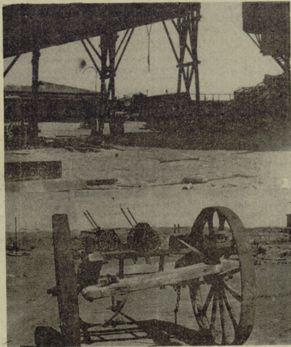
EN PLENO DESIERTO, como símbolo de una época que ya se fue, se alzan los restos de lo que fuera la Oficina salitrera Santa Laura. El ex centro productor del oro blanco ha sido declarado monumento nacional, y será refaccionado totalmente para instalar allí el Museo del Salitre. Mucho es lo que allí se puede conocer de lo que fue la vida en la época del auge de este mineral, sin embargo, es conveniente que se adopten las medidas necesarias para evitar que se siga con su destrucción. LA NACION estuvo en Santa Laura y pudo apreciar cómo se continúa sustrayendo calaminas, fierro, etc., sin importar que así se contribuya a la desaparición definitiva de este verdadero testimonio de una época llena de historia para Chile. Los gráficos muestran dos aspectos del ex centro salitrero. Arriba, lo que fue el pueblo mismo. En la otra foto, carretas que alzan sus brazos de madera al cielo, como implorando que se acuerden de ellas.
