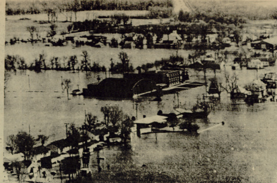
HILLSDALE, ILLINOIS. Una quebradura de la represa entre los pueblos de Hillsdale y Erie, provocó el aumento en el caudal del río Rock River, aguas inundaron un amplio sector en la primera localidad como se observa en la fotografía. Aparecen numerosas casas bajo las aguas y al centro una escuela que alberga a más de 500 estudiantes. RADIOFOTO UPI.
