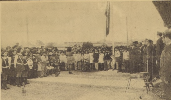
COQUIMBO. Con asistencia de las autoridades, vecinos, estudiantes, brigadas escolares del Tránsito se llevó a efecto, en el sector habitacional de las Encinas, de la nueva población San Juan la entrega oficial del edificio construido para el Retén de Carabineros.
