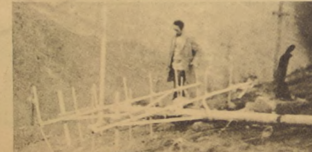
UNA PARTE DE LA ANTENA yace por tierra.
