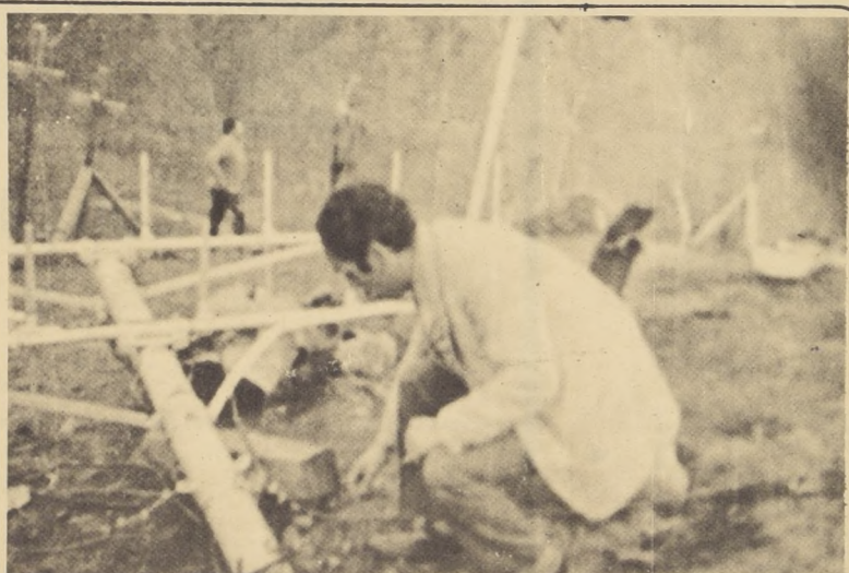
UN TECNICO DE TV Nacional observa los restos de la antena repetidora derrumbada por el dinamitazo.
