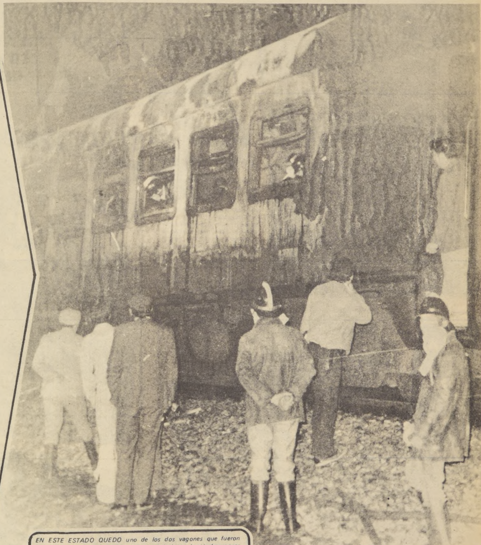
EN ESTE ESTADO QUEDO uno de los dos vagones que fueron incendiados por los derechistas que, amparándose y haciéndose pasar por mineros de "El Teniente", pretendían marchar sobre Santiago. El hecho se registró a la altura del kilómetro 28 de la vía férrea que va al sur.
