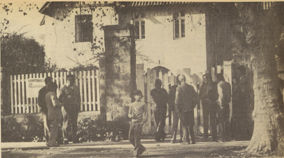
Fachada del inmueble ubicado en Avenida Pedro de Valdivia 2454, lugar donde comenzaron a funcionar los estudios del canal pirata.
