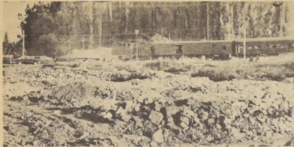
VALPARAISO. Un Terminal pesquero mediterráneo será construido en San Felipe en virtud del Convenio entre la Corporación de Desarrollo de Valparaíso y Aconcagua. En la fotografía, los terrenos para dicho Terminal que están contiguos al ferrocarril y al Camino Internacional y que pertenecen a SILA-CORFO.
