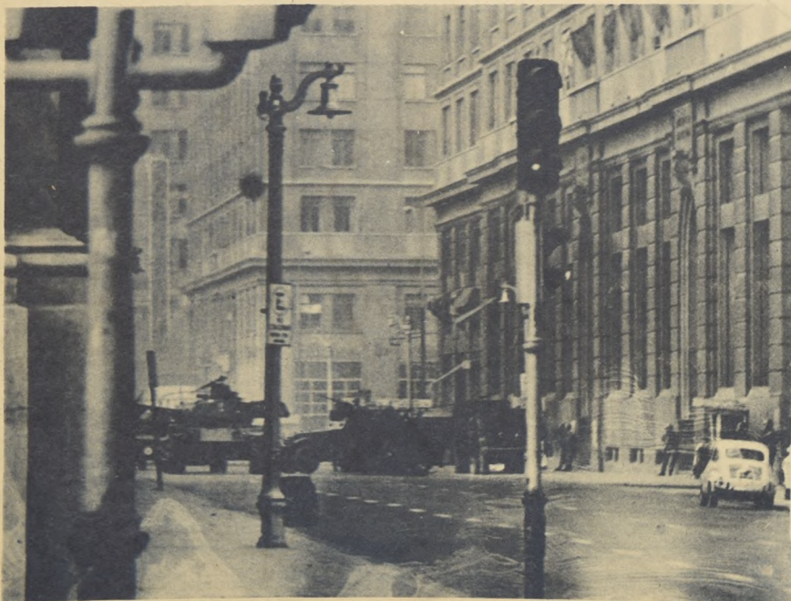
FRENTE AL MINISTERIO de Hacienda las minoritarias tropas insurgentes doblan por la Plaza de La Libertad para tomar posiciones ofensivas frente al Palacio Presidencial, frente a la Plaza Bulnes. Allí quedaron apostados tres tanques, tres camiones orugas y tres s' miorugas.
