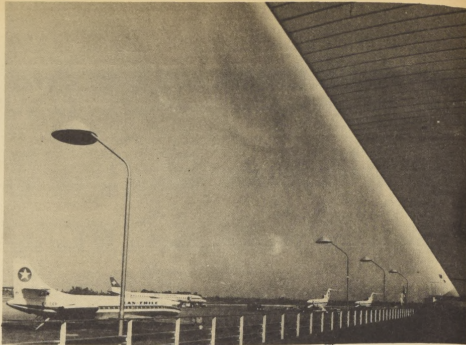
Poco a poco el Aeropuerto Internacional de Pudahuel va alcanzando las modernas líneas que permitirán que este servicio esté a la altura de los mejores del hemisferio sur.
