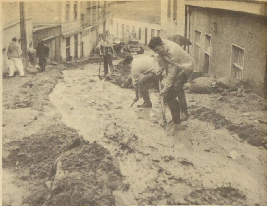
Los trabajadores de la Corporación de Obras Urbanas iniciaron la pavimentación de varias poblaciones con el objeto de evitar a tiempo que se formen los
