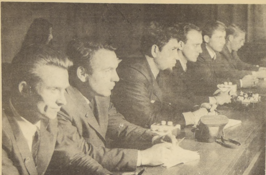
Obreros, técnicos, ingenieros y constructores soviéticos son los jóvenes soviéticos que terminarán la segunda etapa de línea férrea en Ventanas.
