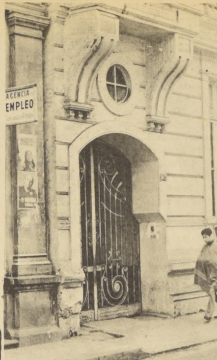
Fachada del prostíbulo donde fue asesinada la asilada, Magdalena Liencura Carrillo, en calle Agustinas 1943
