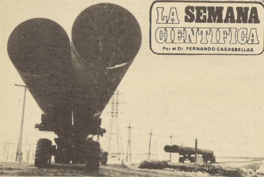
EN ININTERRUMPIDO TORRENTE potentes camiones transportan a las obras tubos de acero que una vez soldados formarán nuevos sectores del gigantesco oleoducto.
