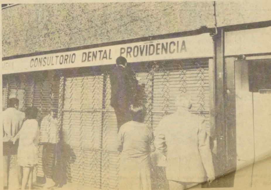
La fachada del Consultorio Dental de SERMENA, ubicado en Carlos Antúnez, frente al que se encontraba estacionada la camioneta de INDAP, muestra numerosos impactos de balas disparadas por los terroristas de derecha en su acción comando, que culminó con el asesinato del Comandante de Marina, Arturo Araya Peeters.
