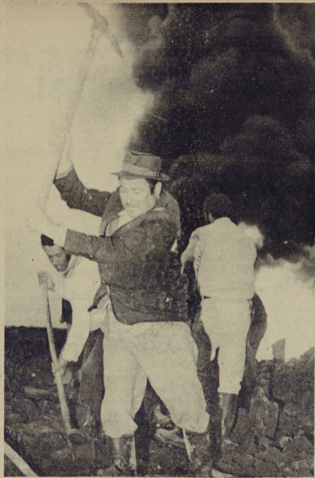
¡ASI RESPONDE EL PUEBLO a la turia demente y destructora del fascismo criollo! Armados de palas y otras herramientas, los trabajadores han laborado, incansablemente en reparar los graves daños en el gasoducto que fue volado por los nazis.
