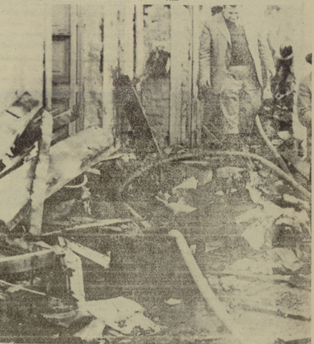
Al fondo de este pasillo comenzó el incendio donde explotó el balón de gas licuado.
