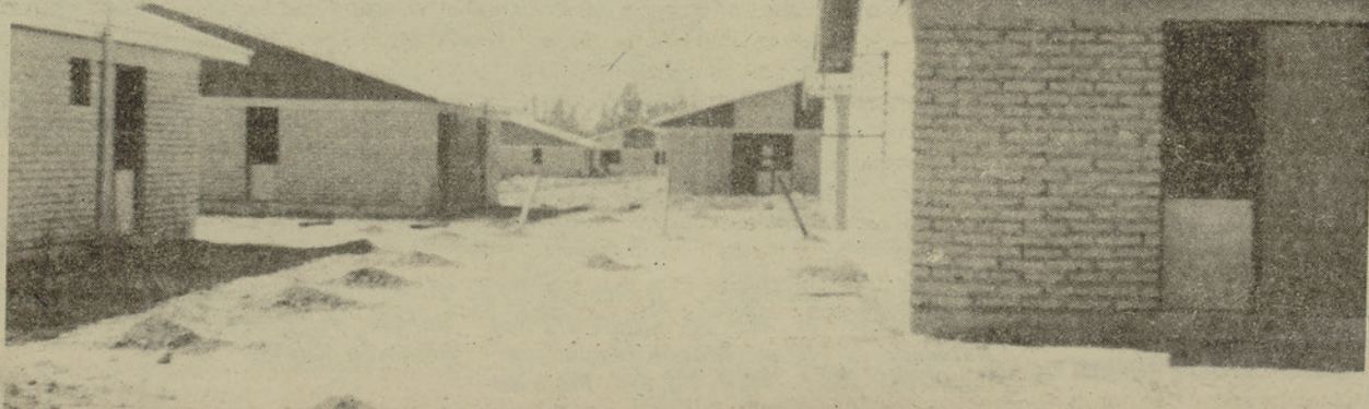
Casas terminadas que no pueden ser habitadas debido a que no hay camiones para trasladar los postes del alumbrado. Los trabajadores no reciben materiales de obra y los pobladores sus casas, a causa del paro fascista de los camioneros.
