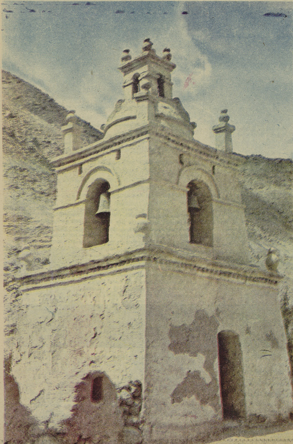
Torre-campanario de la iglesia de Guañacahua, adobe y piedra para una original solución arquitectónica.
