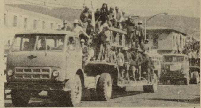
VALPARAISO. Camiones de la Planta de Viviendas donada a Chile por la URSS, desfilaron por las calles de Valparaíso en apoyo al Gobierno, con sus trabajadores, entre las que destacaban las jóvenes gueras que laboran en dicha fábrica, en El Belloto. Cabe agregar que ya hay varios edificios KPD terminados en base a esta nueva técnica. (Foto Oscar Luis Arriagada).
