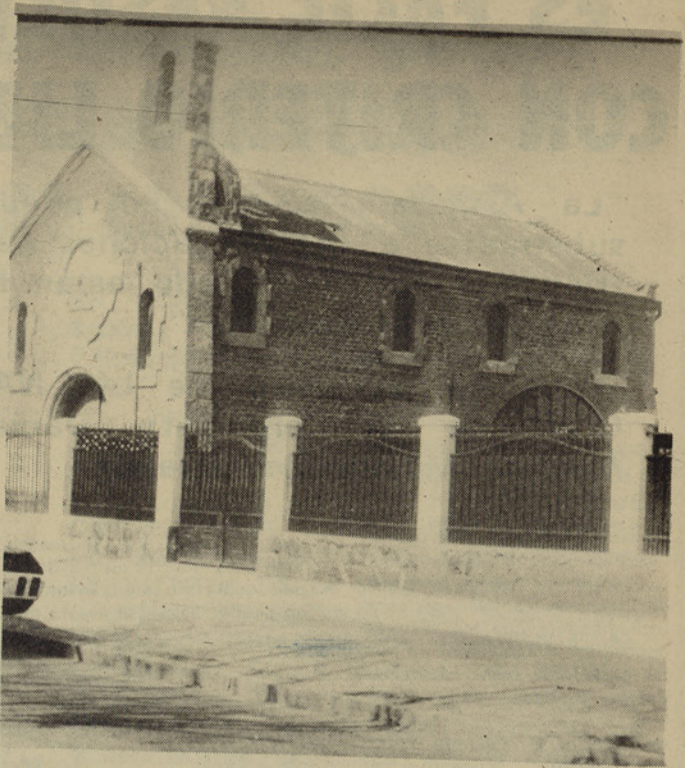
En Simón Bolívar 2843, interior, residencia del Cardenal Raúl Silva Henríquez, cuatro individuos efectuaron cuatro disparos hacia el inmueble, donde se encontraba un Carabinero de servicio.
