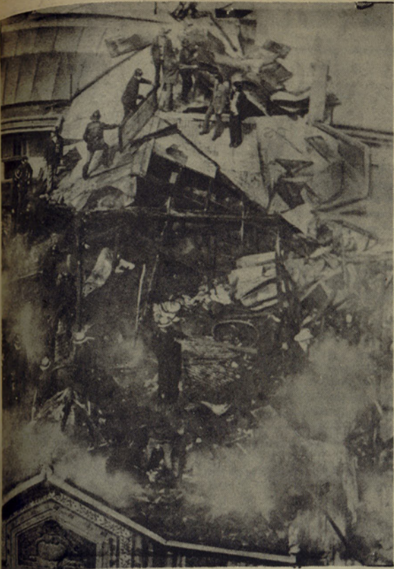
VOLUNTARIOS DE BOMBEROS trabajan entre los restos humeantes del tejado y segundo piso del edificio de la Juventud Radical Revolucionaria, incendiada intencionalmente en la mañana de ayer.
