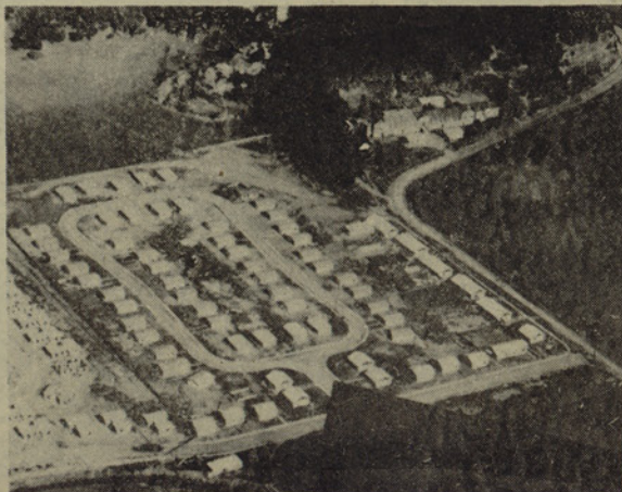
Viviendas en plena construcción en Arauco, para los trabajadores de esa Celulosa.
