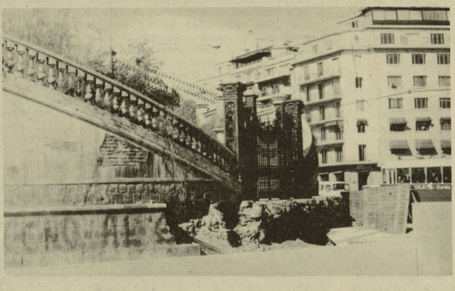
EL CERRO SANTA LUCIA SE REMOZA. Prosiguen los trabajos de transformación del primer paseo santiaguino, tras la terminación del Paso Bajo Nivel. El grabado muestra la entrada principal, cuya escala debió ser sacada en forma provisional a fin de instalar cañerías de agua potable.
