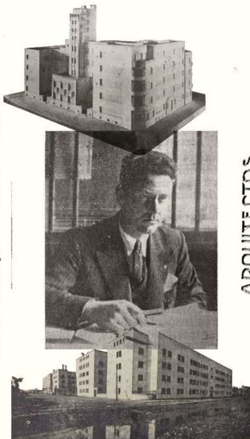
3.—«COMPLEJO "SAN EUGENIO".— Vista general de los pabellones de líneas severas y bien orientados hacia el aire y la luz... Es otra de las múltiples realizaciones prácticas de la Caja en favor de los asegurados
